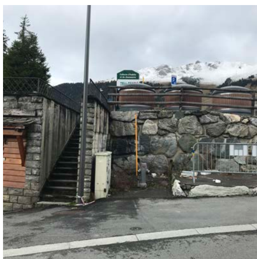
Accès Sud-Est vers la zone des containers, depuis le chemin des Vernes. Photo RDR 20Le 22.
